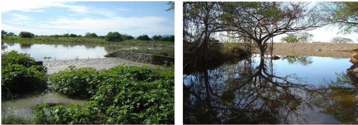
Figura 4. Bordos con material vegetativo en estructuras y vaso de almacenamiento.
